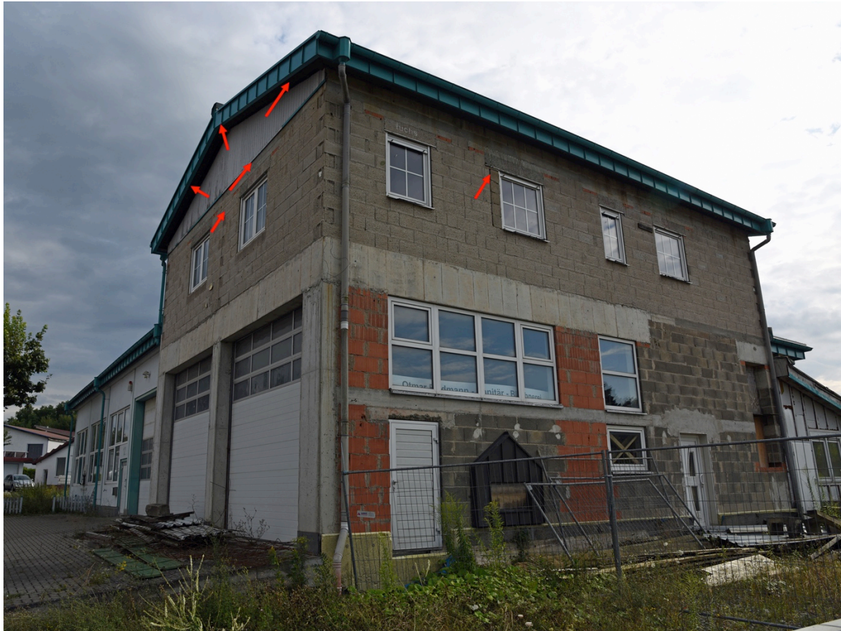
Abbildung 10: Das durch die Telemetrie der Grauen Langohren im August 2016 gefundene zweite Quartier (Q2) im Gewerbegebiet Flehingen.
