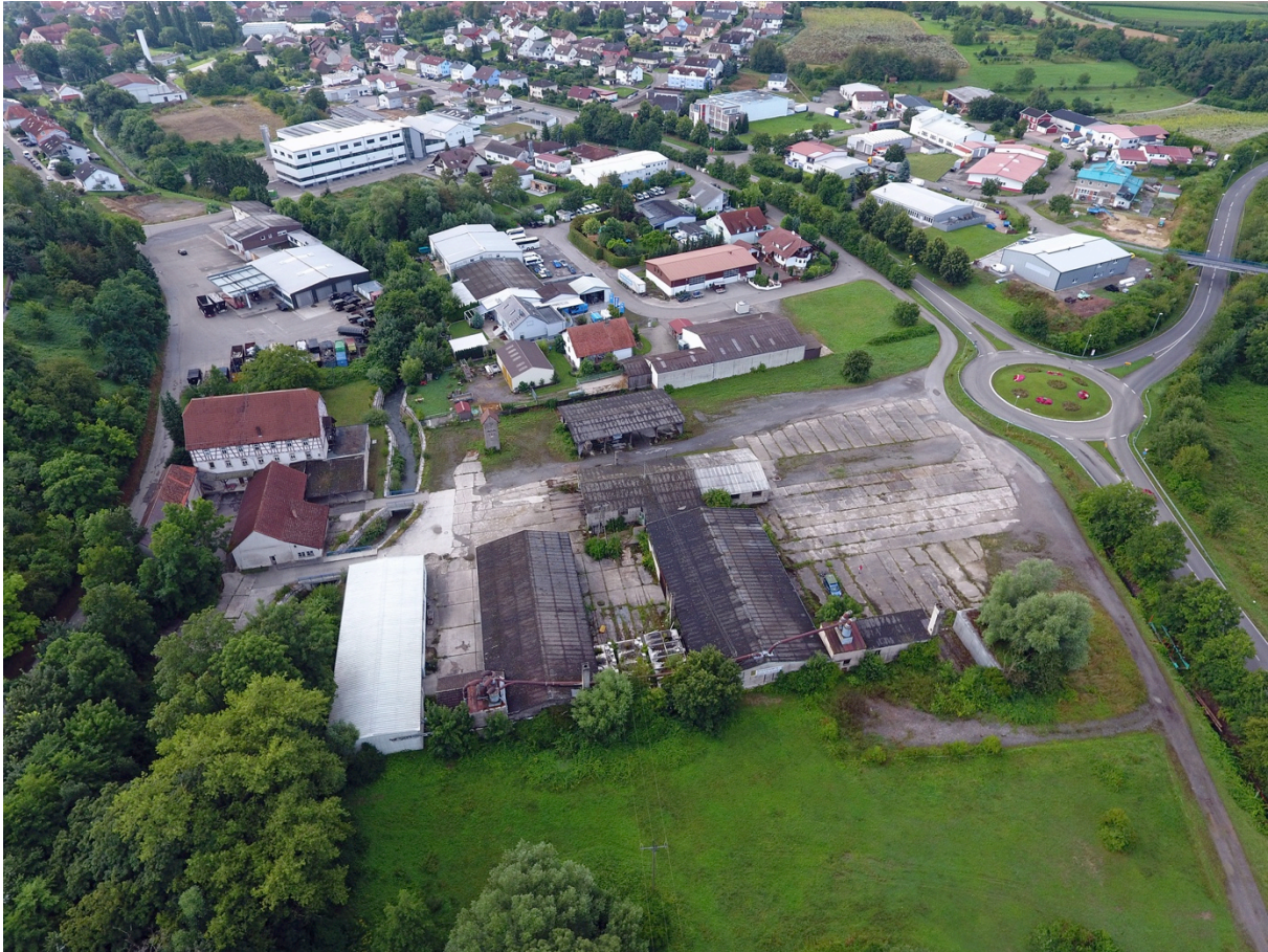
Abbildung 2: Schrägluftbild des Untersuchungsgebietes von Nordwesten. In der unteren Bildhälfte sind die leerstehenden Gebäude der Firma Braxmeier zu sehen, links in der Bildmitte der Gebäudekomplex der Alten Mühle. Foto: Dietz.
