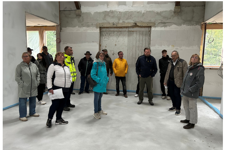
Flehingen: Projekt Güterhalle: Sanierung u. Nutzungsänderung zu einem Kindergarten, Bahnhofstraße
